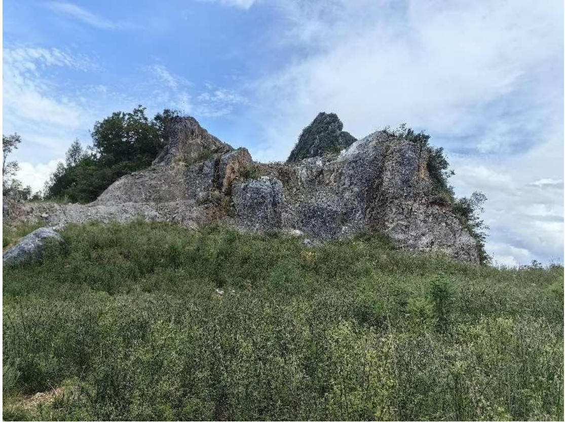
照片5：巫溪县城厢镇五新村1社采石场采场底盘与采场边坡
