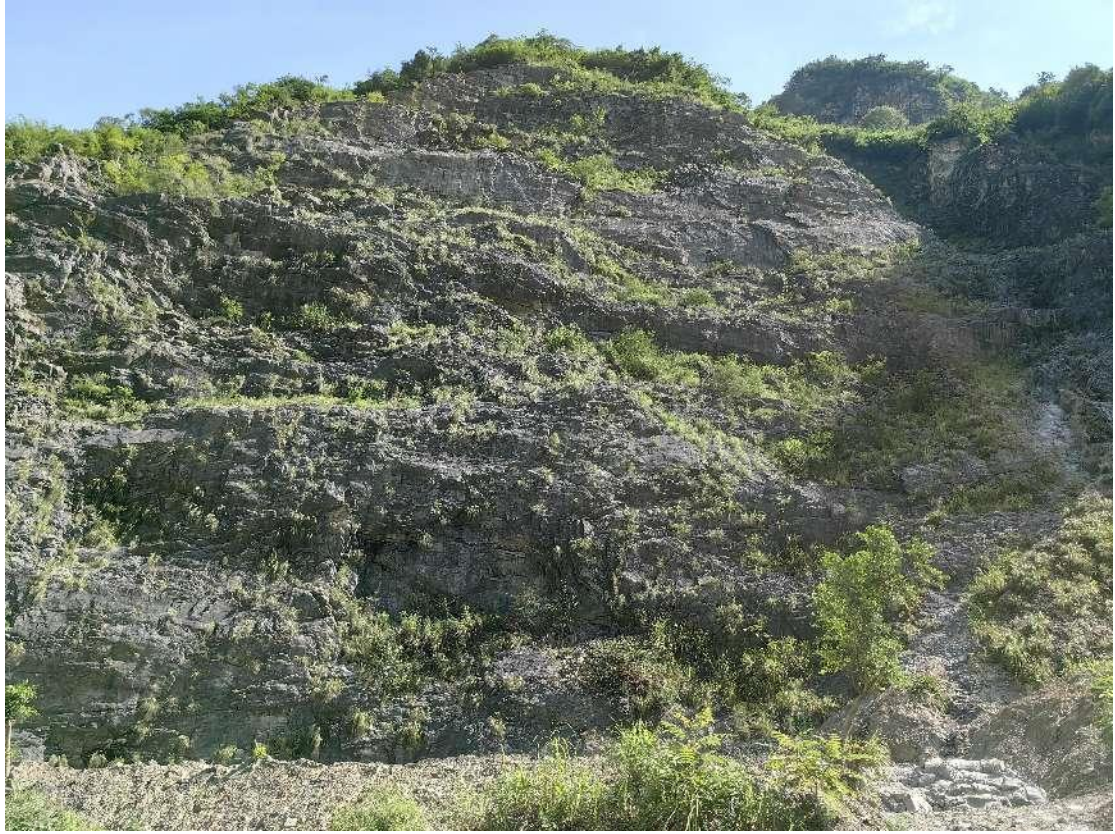
照片3：巫溪县沈耀福采石场采场边坡
