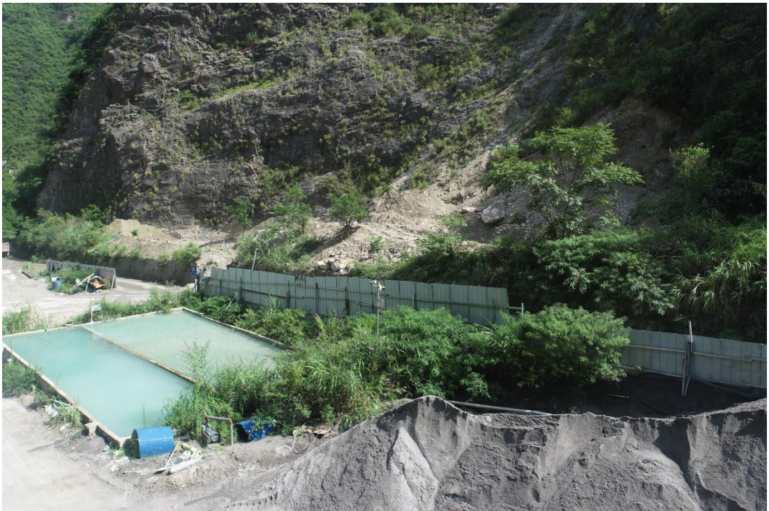
照片2：巫溪县沈耀福采石场工业广场
