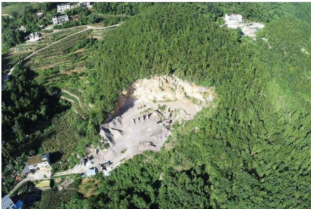
照片4：巫溪县峰灵镇龙寨村碎石加工厂全貌照
