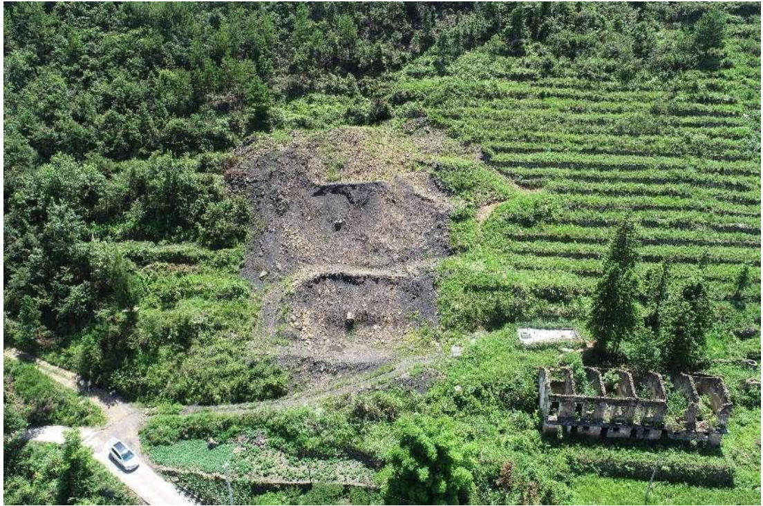
照片10：巫溪县峰灵镇庙溪村煤矿全貌照
