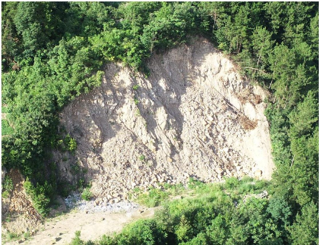
照片9：巫溪县水泥厂原材料厂采场边坡
