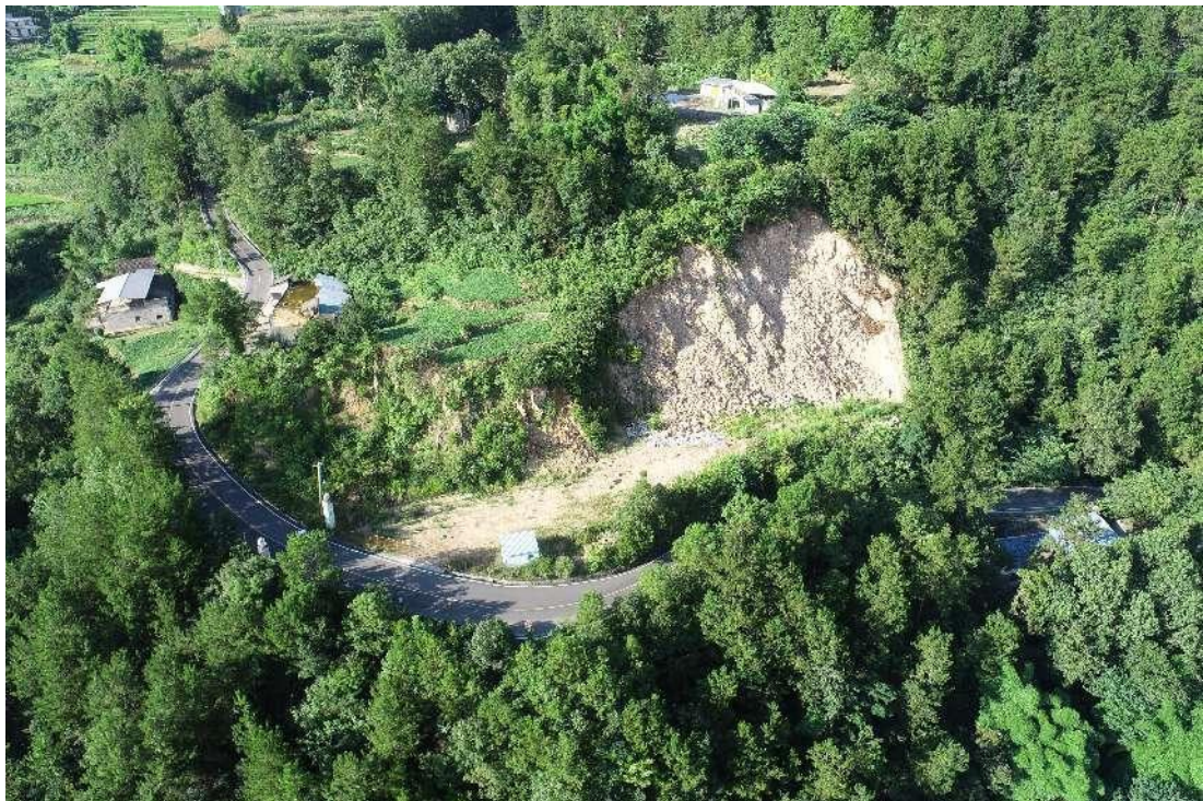
照片7：巫溪县水泥厂原材料厂全貌照
