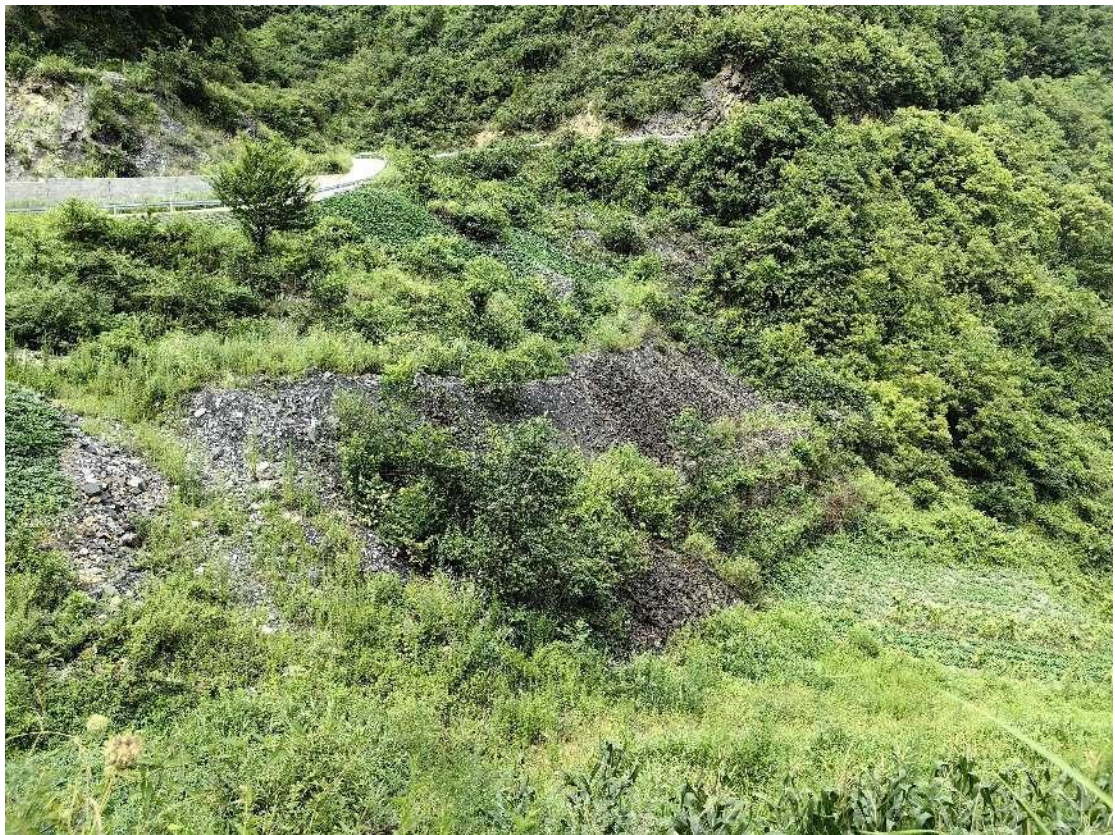
照片7：巫溪县龙山煤矿有限责任公司煤矸石堆积边坡
