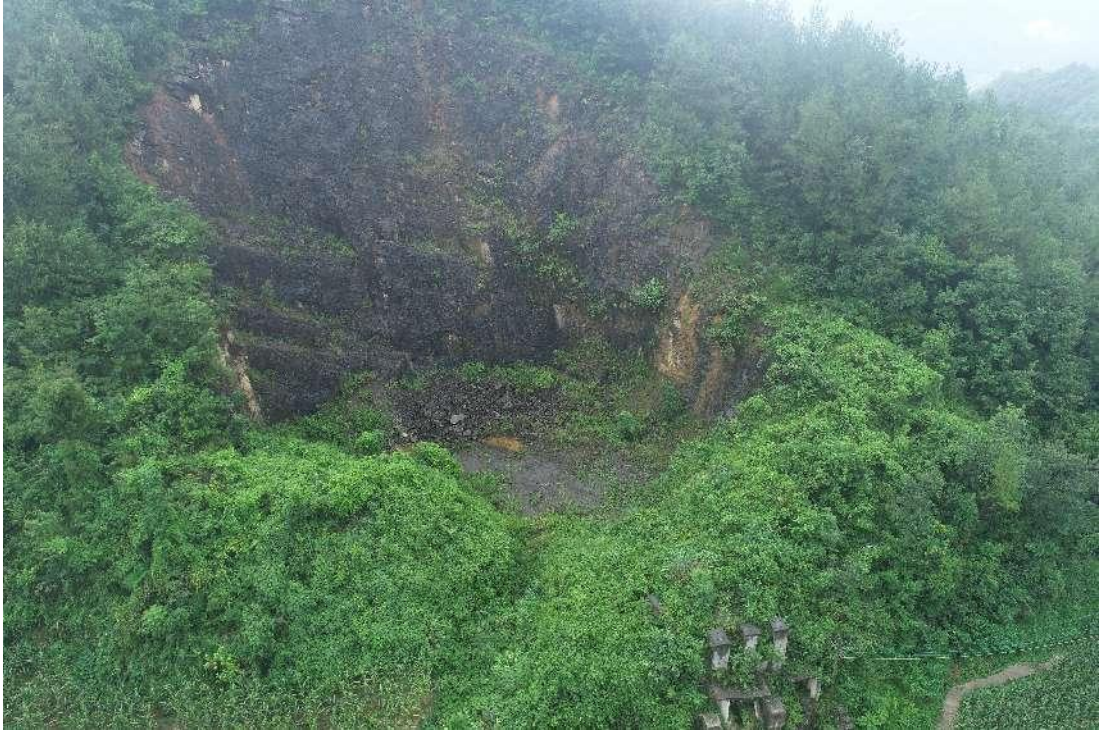
照片4：巫溪县上磺镇友谊村建筑石料用灰岩矿采场底盘与采场边坡
