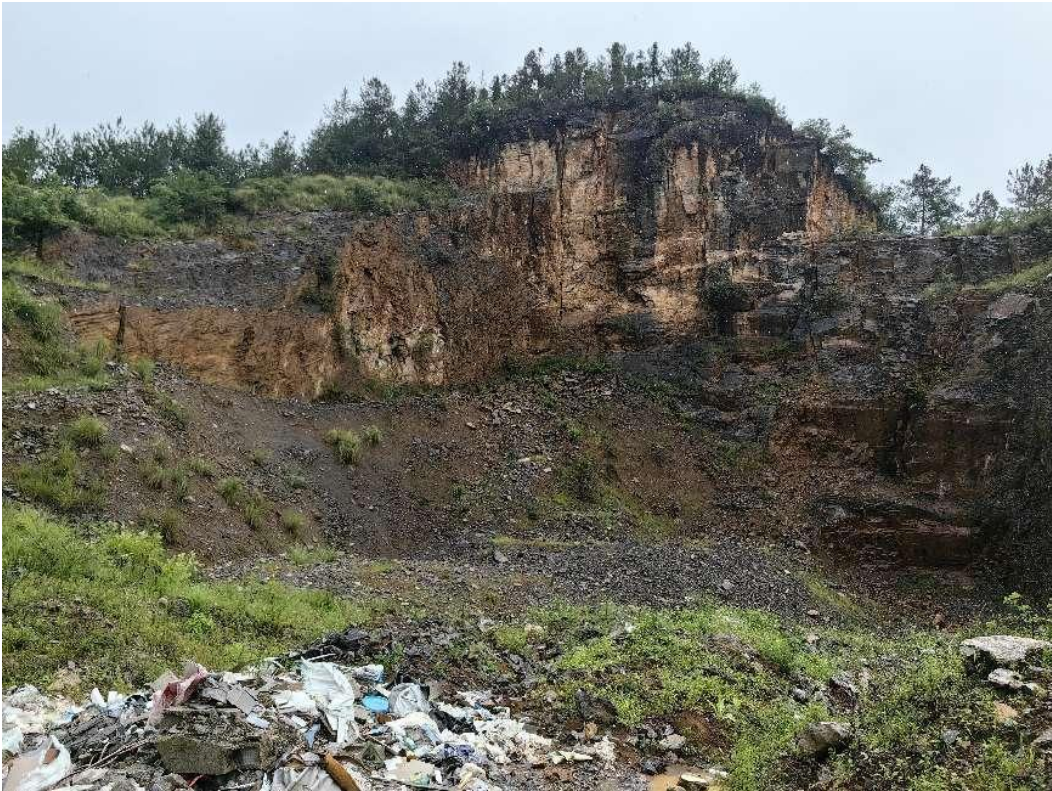
照片2：巫溪县上磺镇石峰村采石场采场底盘与采场边坡
