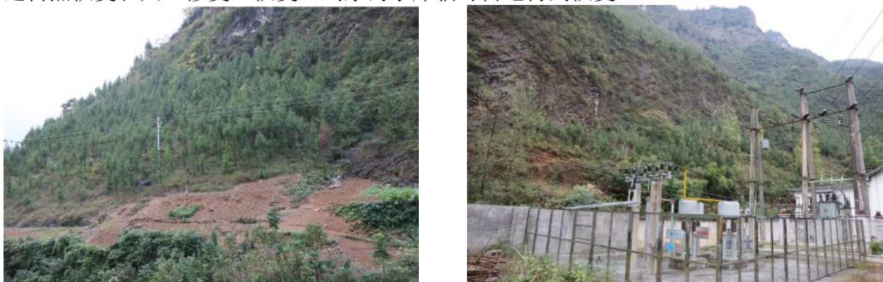
图2.1-4 刘家沟电站厂房及周围山体
