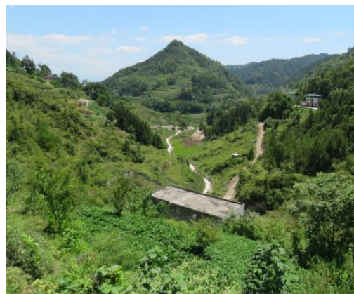
图2.1-8 柏杨电站厂房
