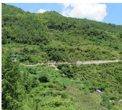
图2.1-7 柏杨电站压力管道
