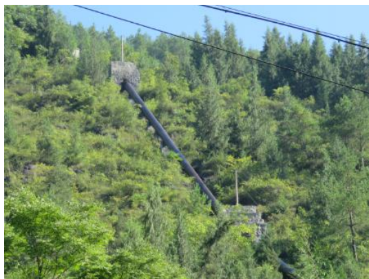
图2.1-5 石龙电站压力管道
