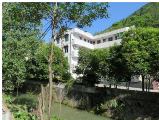
图2.1-6 石龙电站厂房
