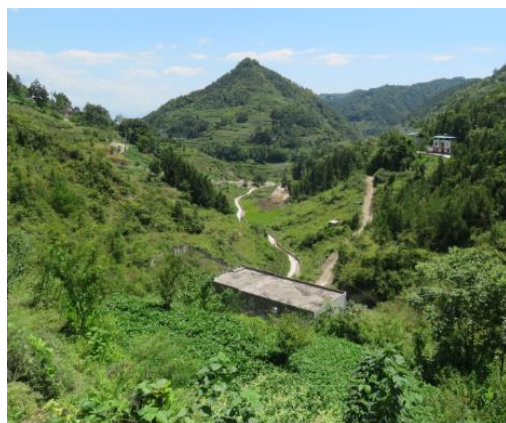
图2.1-8 柏杨电站厂房
