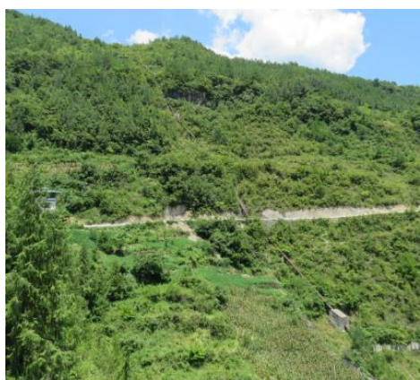
图2.1-7 柏杨电站压力管道
